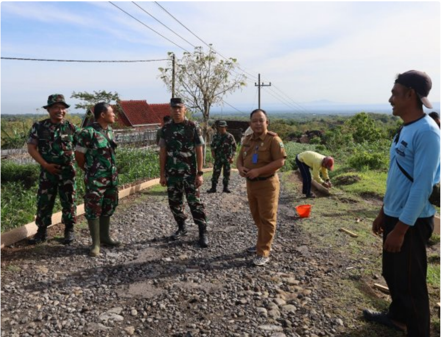
TNI Manunggal Rakyat: Kodim 0804/Magetan Karya Bhakti Pengecoran Jalan
